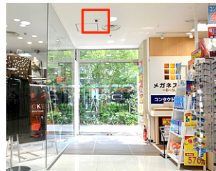
出入口付近には複数の監視カメラを設置し、館内の隅々まで安全安心を徹底。
