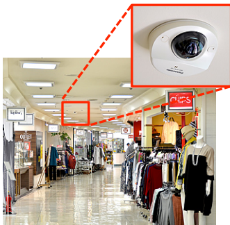
お客様に圧迫感を与えないコンパクトなドーム型監視カメラを設置。
