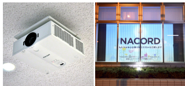
夜間は、天井に設置したプロジェクターから採光ブラインドに映像を投影し、店外へ情報発信をしています。
